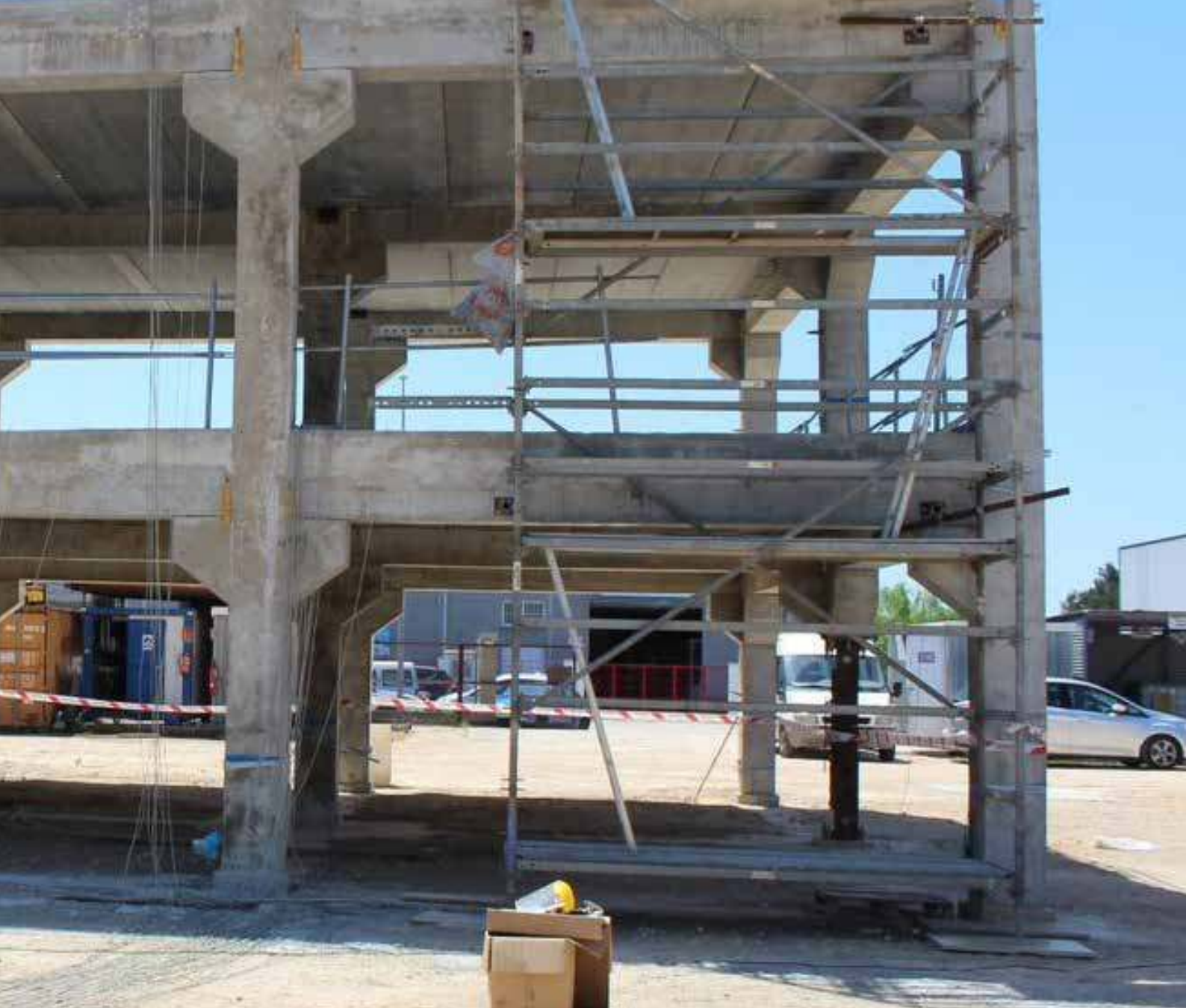
Imagen del edificio diseñado por la UPV en el marco del proyecto PREBUST'
